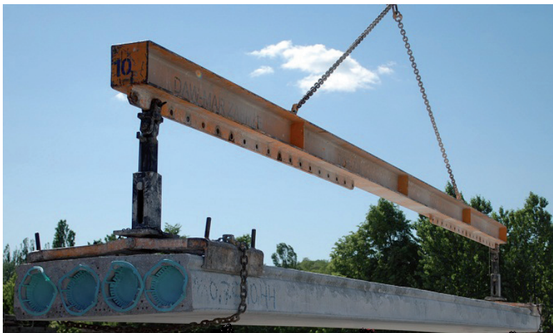
Rysunek 1. Przenoszenie płyt stropowych za pomocą trawersy
