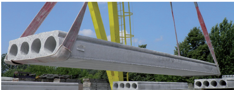
Rysunek 2. Przenoszenie płyt za pomocą pasów
