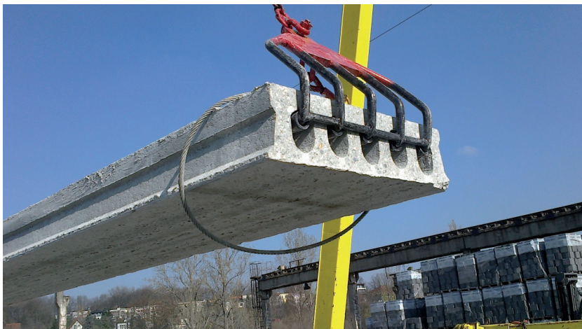
Rysunek 3. Przenoszenie paneli SMART za pomocą chwytaków
