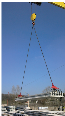
Rysunek 4 Przenoszenie płyt za pomocą zawiesi hakowych Rysunek 5 Długość i kąt zawiesi podczas podnoszenia paneli SMART
