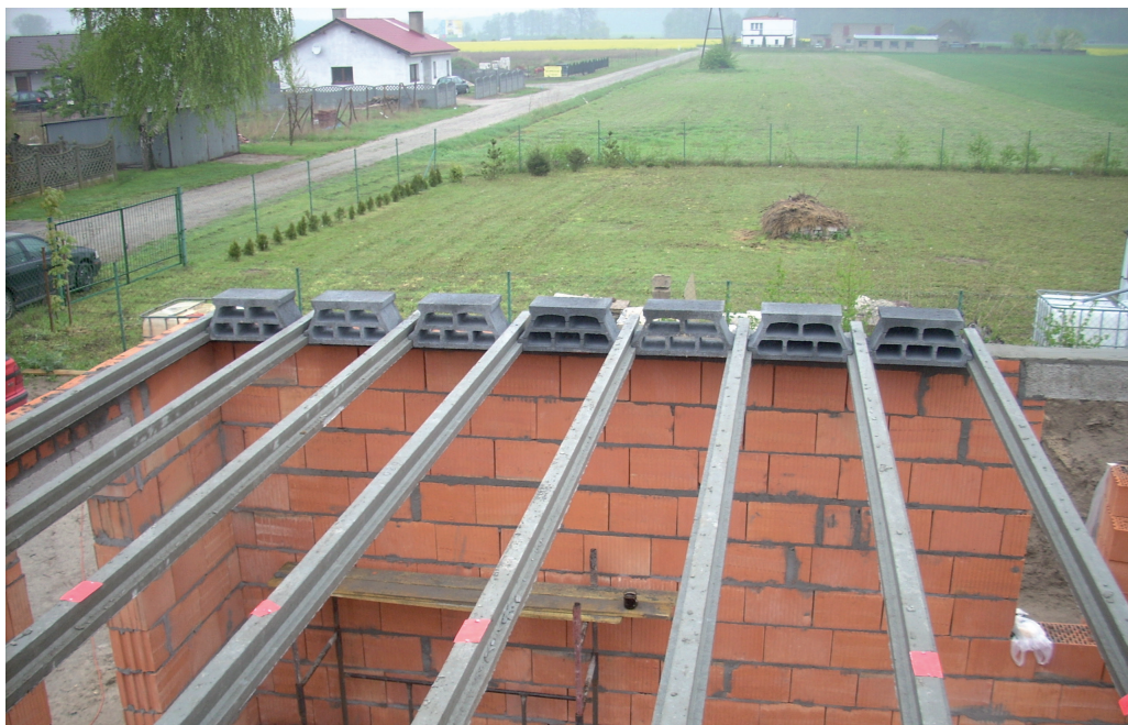
Fot. 1 Układanie belek na ścianach
